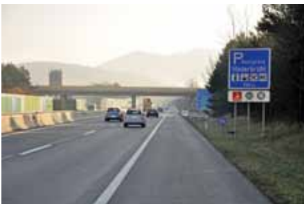
Der gesamte Verkehr wird ...
